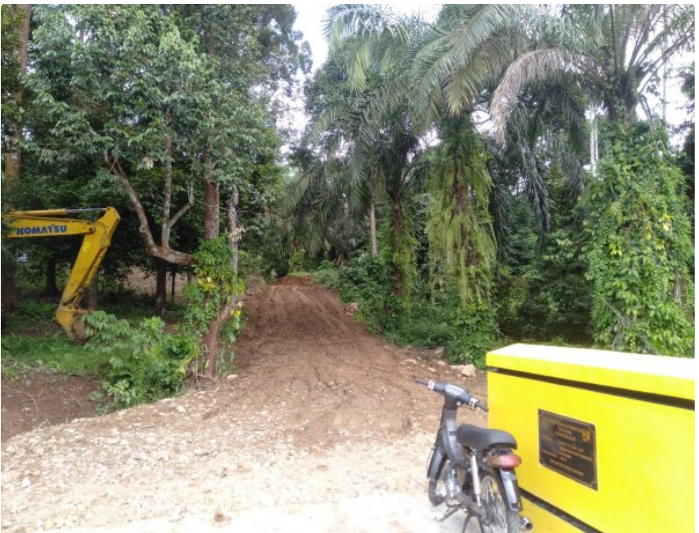
Jalan baru Banda Talang ke Buah Kasok belum diaspal
